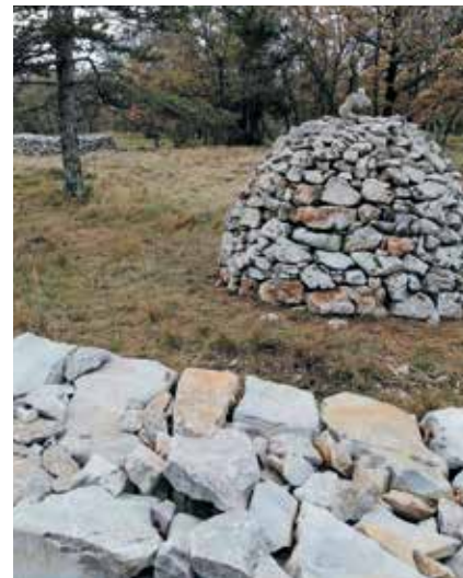
Poligon suhozidne gradnje v Živem muzeju Krasa v Sežani so zgradili izvedenci suhozidne gradnje
