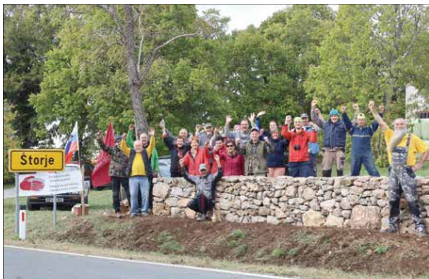
Konec je! – v Štorjah so dokončali 53 metrov novega suhega zidu (Slika: David Terčon).
