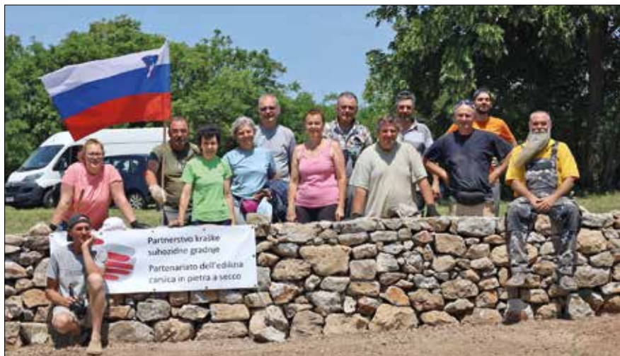
Zadnja izmed treh junijskih suhozidnih delavnic v Štorjah je bila v soboto, 18. junija 2022.
