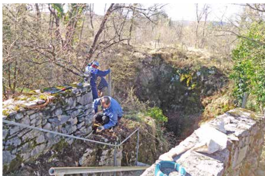
Urejanje vhodnega dela v jamo.
