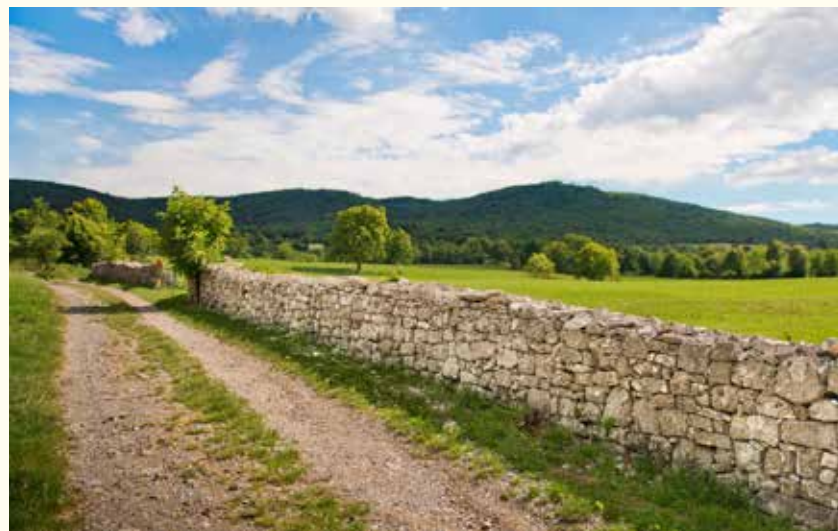
Suhi zid. Slika: Andrej Muravec.
