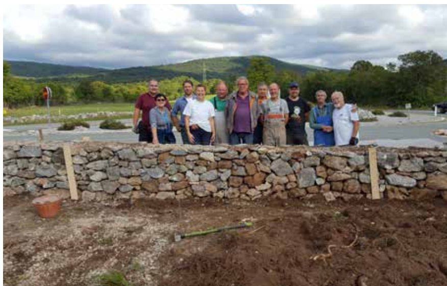
Udeleženci akcije gradnje suhega zidu. (Slika: arhiv KS Štorje).
